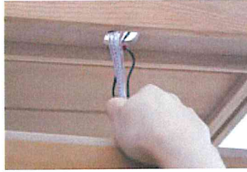
Ziehen Sie die Kabel durch das Dach
